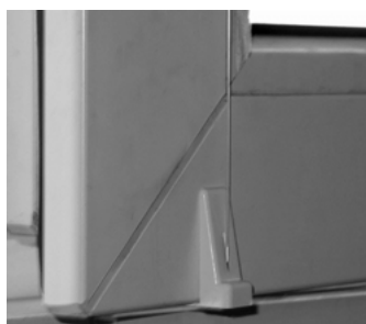
Рис. Установленный кронштейн в сборе
